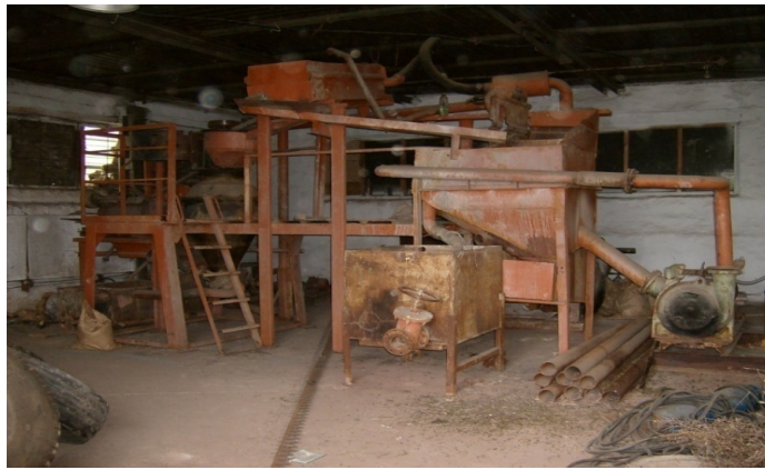
Общий вид опытно-промышленной установки
